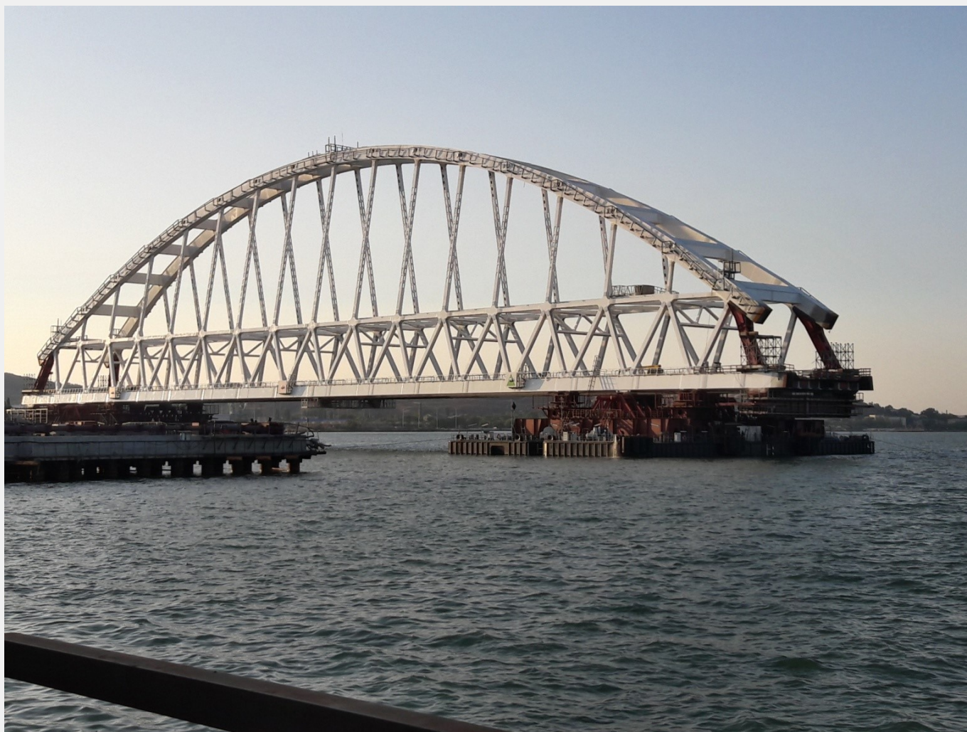
Плавучая система с пролетным строением Крымского моста на оси подходного канала 27 августа 2017 г. (фото АО «ЦКБ «Коралл»)
