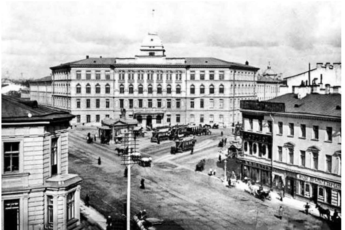
Технологический институт и дом на месте станции метро «Технологический институт», фотография начала XX-го века.
