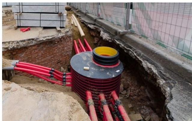
Рис. 1. Общий вид коллектора со смотровым колодцем
