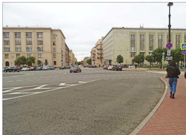
Западная часть площади Пролетарской диктатуры. Слева – дом Совнархоза (1957), справа – дом Политпросвещения (1974)
