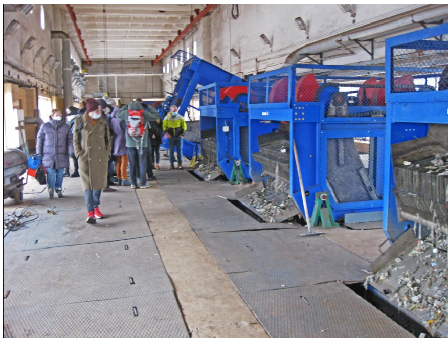
Фото 4. Зал механических решёток
