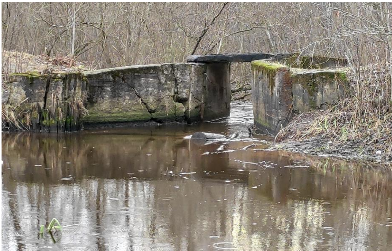
Рис. 1. Фото водопропускного сооружения
