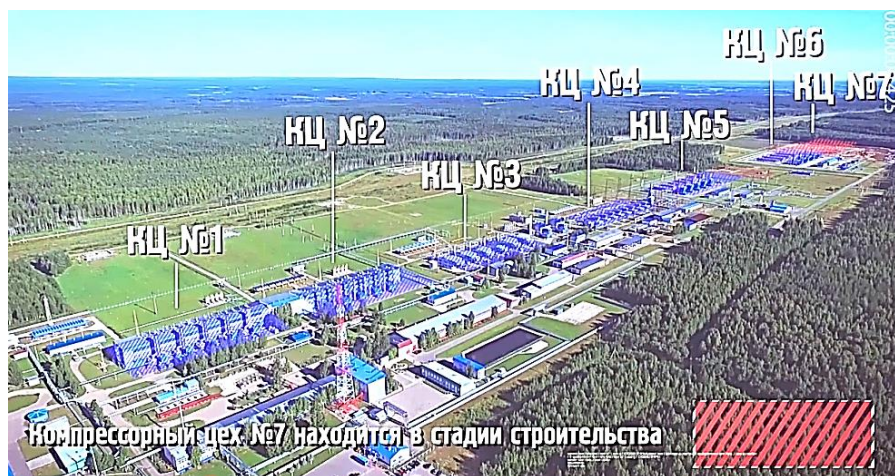
Рис. 1. Площадки компрессорных станций
