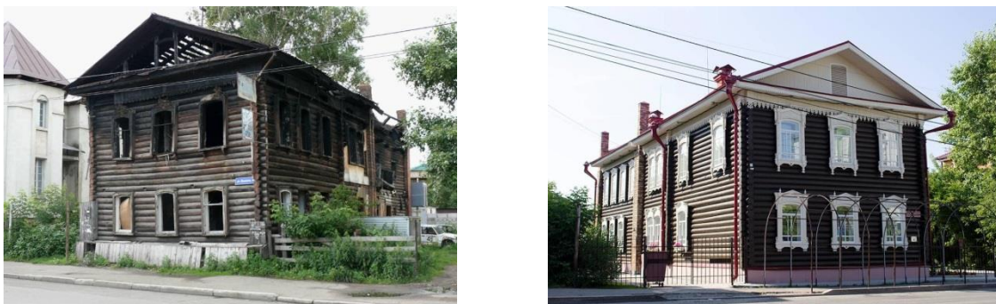
Рис. 1. Дом 5 на ул. Пушкина до и после проведения работ по восстановлению Е. Калугиным
