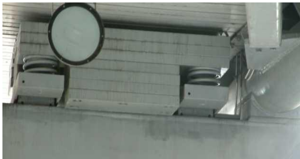
Рис. 1. Жидкостной вязкий демпфер
