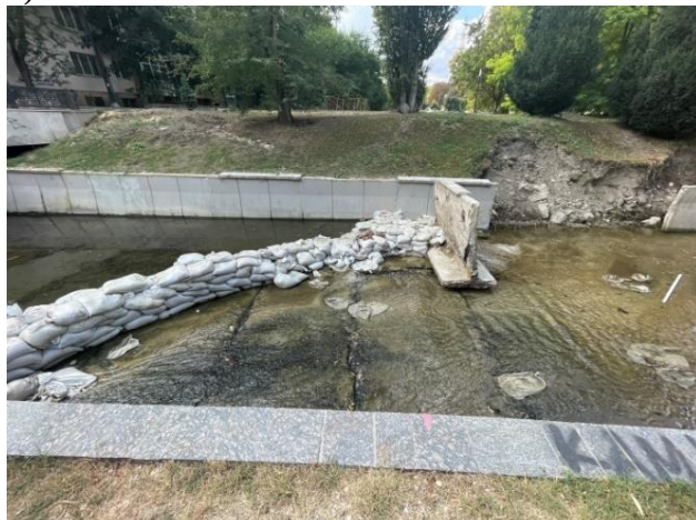
Рис. 3. Участки, характеризующиеся неудовлетворительным техническим состоянием укрепительных сооружений: а – р. Салгир в районе ул. Воровского; б – р. Салгир в районе ул. Ракетная
