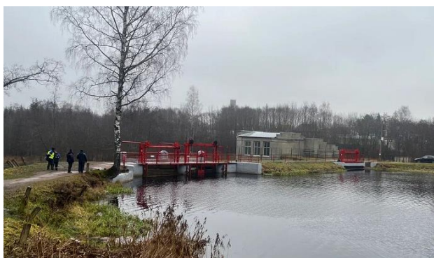
Рис. 1. Вид на гидроузел Рождественской МГЭС
