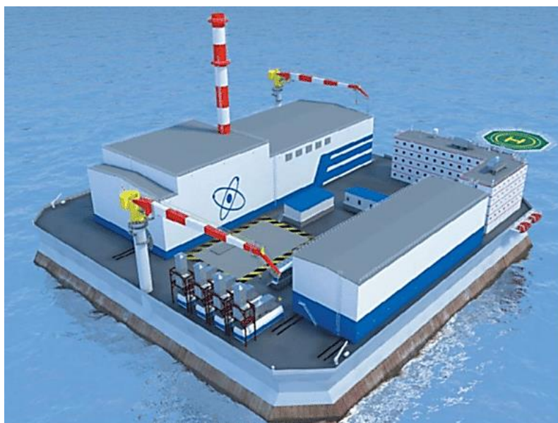
Рис. 1. Транспортабельная АЭС с ядерной установкой ВВЭР-300 на ледостойкой платформе
