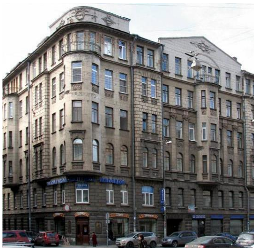
Рис. 1. Общий вид здания
