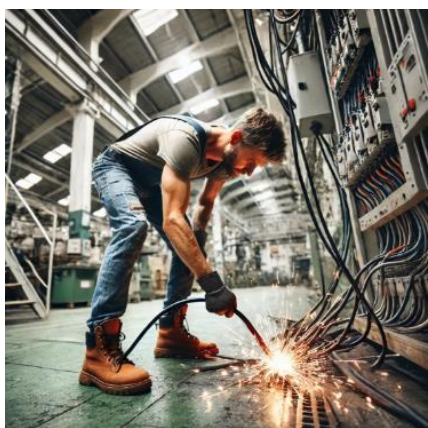
Рис. 1. Нарушение правил при выполнении работ в электроустановках
