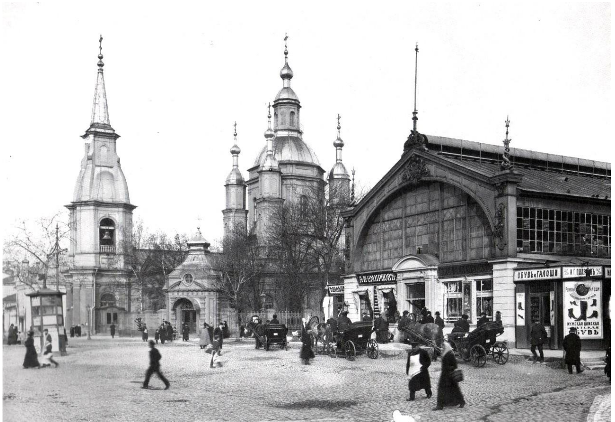
Рис. 31 Андреевский рынок, корпус на основе металлоконструкций, проект архитектора графа П. Ю. Сюзора, 1891-й год
