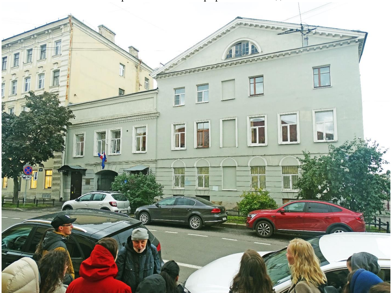
Рис. 23 Дом А. Н. Баландиной, современное состояние. На западном фасаде исчезла ложная аркада
