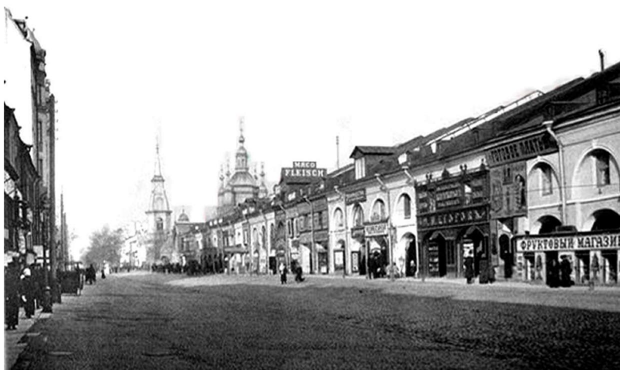
Рис. 30 Андреевский рынок, искажение фасадов. Между кирпичным корпусом и Андреевским собором виден торец павильона, построенного на основе металлических конструкций. Фотография 1900-х годов
