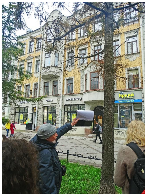
Рис. 27 Дом Изотова, архитектор В. В. Шауб, 1910-й год, венско-немецкий модерн. Внимание студентов обращено на использование облицовочного кирпича и штукатурки разной фактуры
